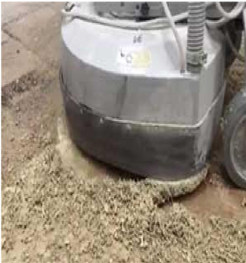
Les outils PCD avec barres sacrificielles ou bouton de liaison métallique sont conçus pour enlever le revêtement sur une surface égale à une surface à la taloche et n'endommageront pas le béton. Les barres sacrificielles ou le bouton en métal agissent comme un stabilisateur et un guide de profondeur et réduisent le calibrage du sol provoqué par les segments
