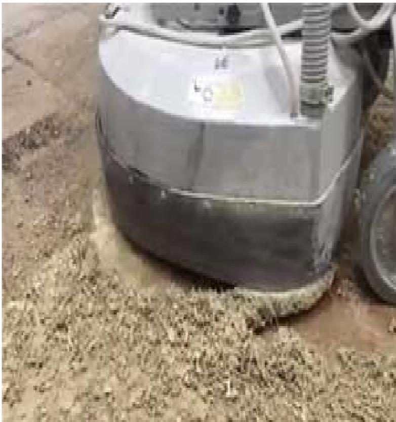
PKD-Werkzeuge mit Opferstangen oder Metallbindungsknopf sind so konzipiert, dass sie die Beschichtung auf einer Oberfläche entfernen, die der Oberfläche einer Spachtel entspricht, und den Beton nicht beschädigen. Die Opferstangen oder der Metallknopf wirken als Stabilisator und Tiefenführung und verringern die durch die aggressiven Leiterplattensegmente verursachte Bodenabmessung. Diese Werkzeuge eignen sich zum Entfernen von:
